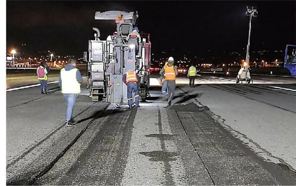
de la plataforma de aeronaves del AML, la reposición de 10km de juntas constructivas del pavimento rígido, bacheo menor en un área de 450 m<sup>2</sup>, finalmente, se realizó la señalización horizontal del área de movimiento, lo que permitió contar con los pavimentos funcionales para una operación segura de las aeronaves.
